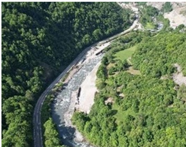
Chantier de renaturation de la Moyenne Romanche
